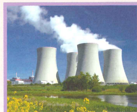
jaderná elektrárna, Temelín
